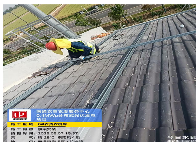
6#农资农机库东侧屋面横梁安装
