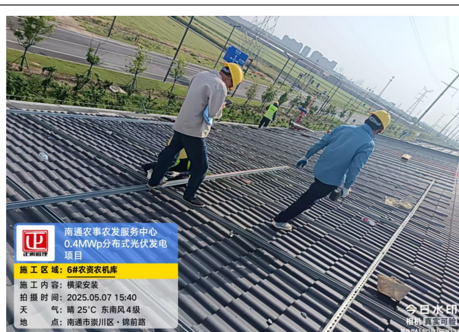
6#农资农机库东侧屋面横梁安装
