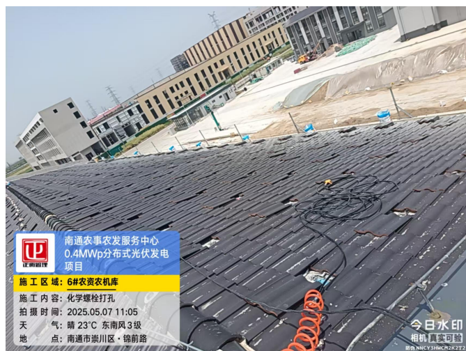
6#农资农机库西侧屋面化学螺栓打孔、清孔施工
