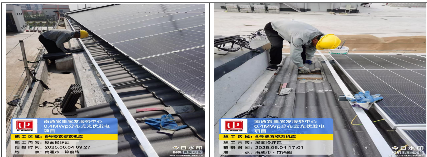
6#农资农机库屋面换坏瓦片消缺
