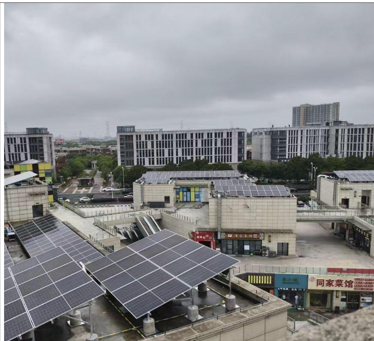
无人施工，巡视检查现场情况，无安全隐患
