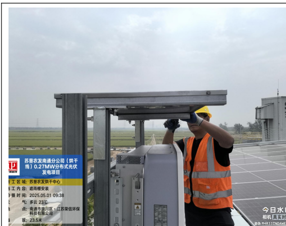
逆变器遮雨棚安装
