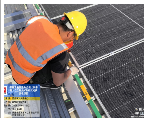
防雷接地施工
