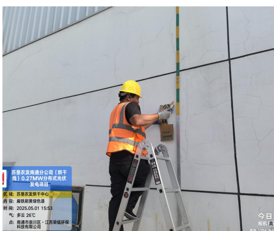
防雷接地施工
