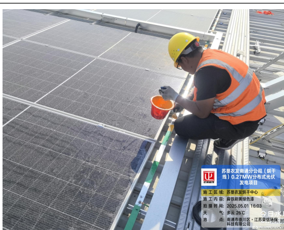
防雷接地施工
