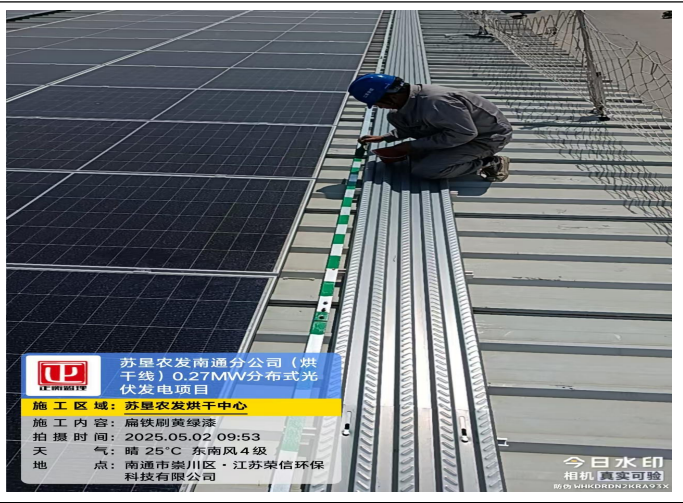
防雷接地施工
