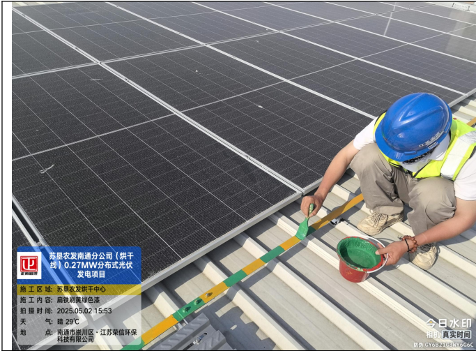
防雷接地施工
