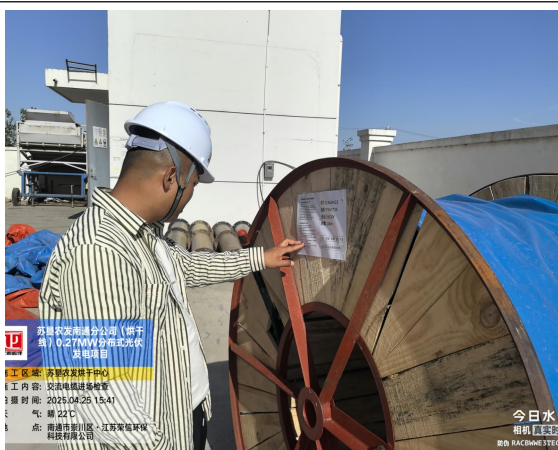
交流电缆进场检查
