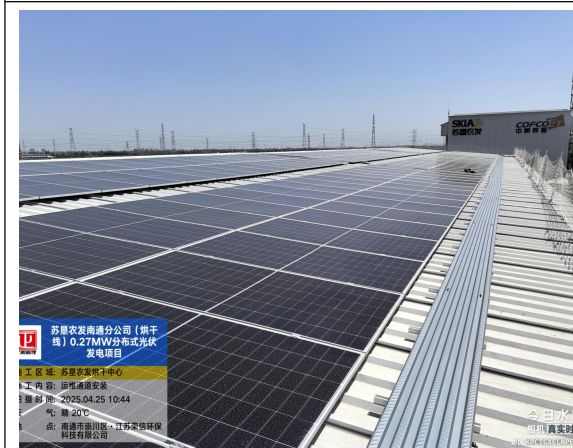
运维通道安装
