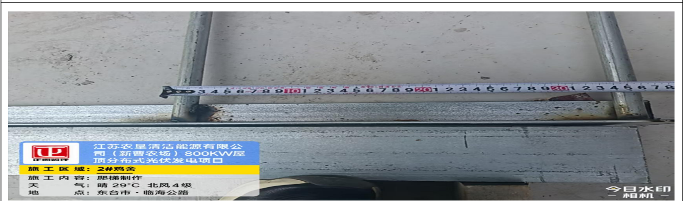
爬梯制作时发现踏棍间距与图纸不符，图纸要求 300mm，现场为 350mm
