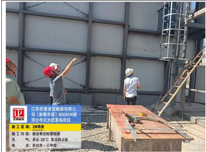
建设单位检查现场
