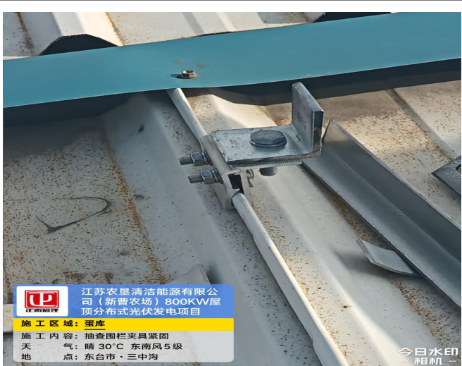
抽查蛋库围栏夹具安装, 紧固
