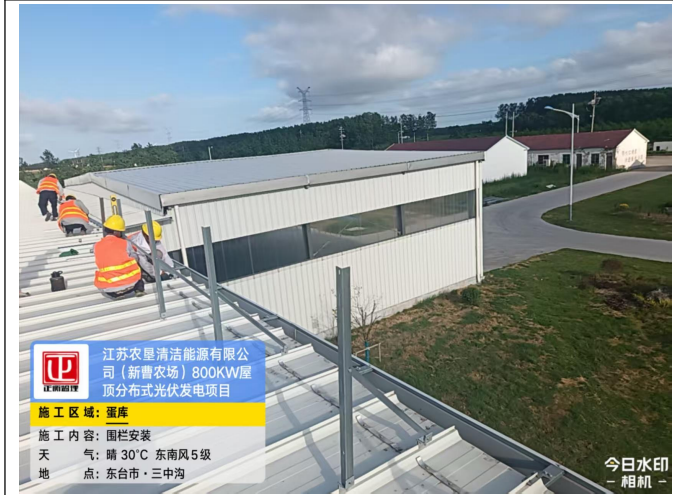
蛋库围栏安装
