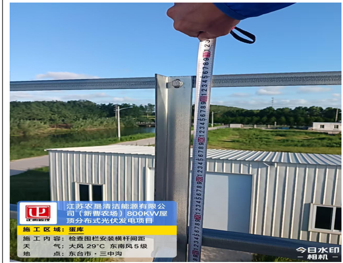
检查围栏横杆间距, 符合设计要求
