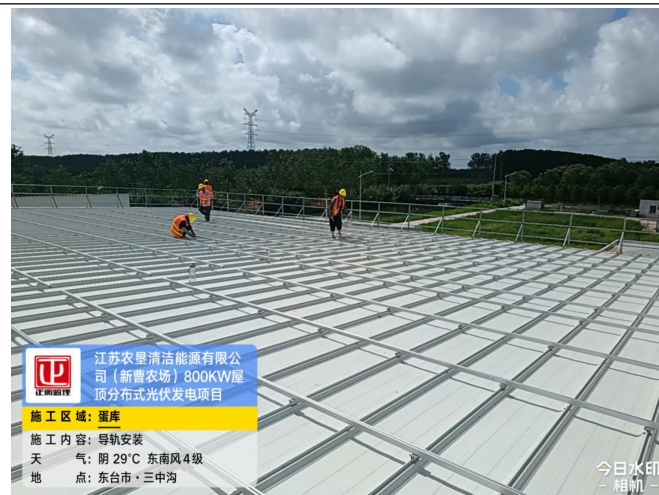
蛋库导轨安装
