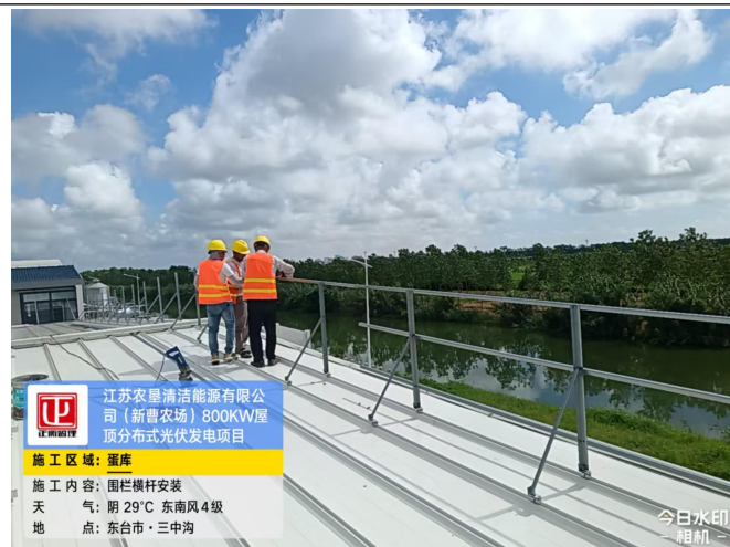
蛋库围栏横杆安装
