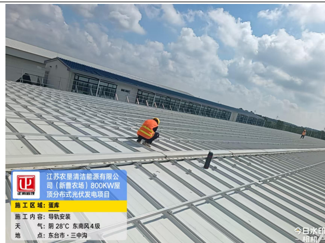
蛋库导轨安装
