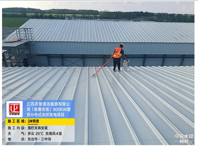
2#鸡舍围栏夹具安装
