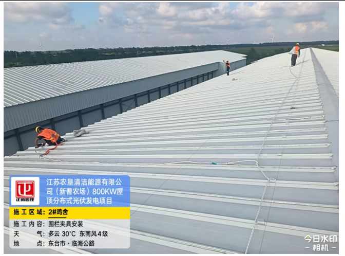
2#鸡舍围栏夹具安装
