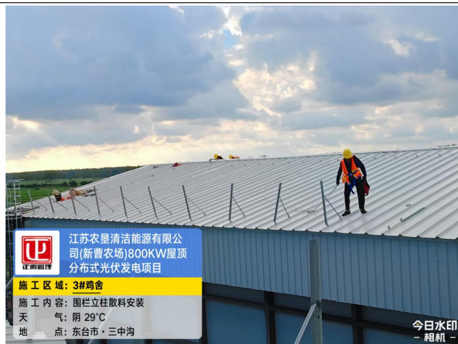
3#鸡舍围栏立柱散料、安装
