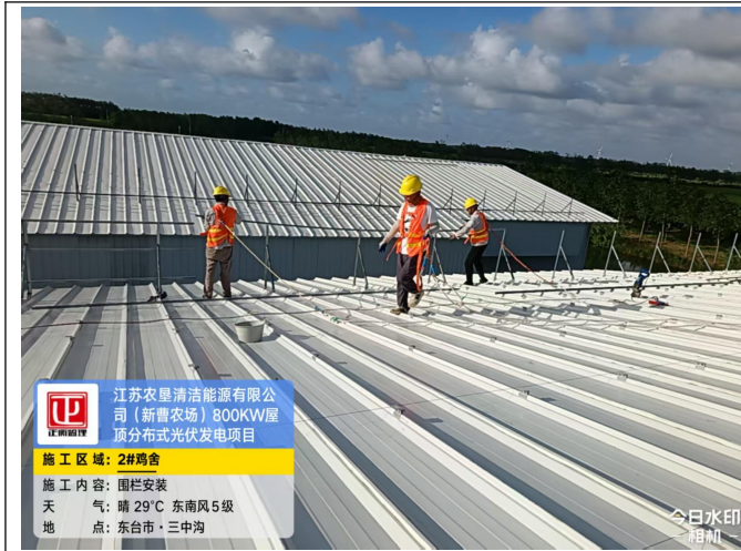
2#鸡舍围栏安装
