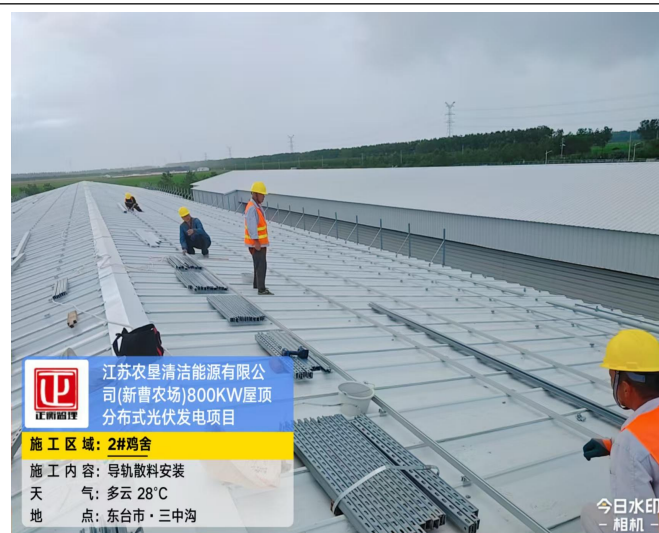
2#鸡舍导轨散料、安装
