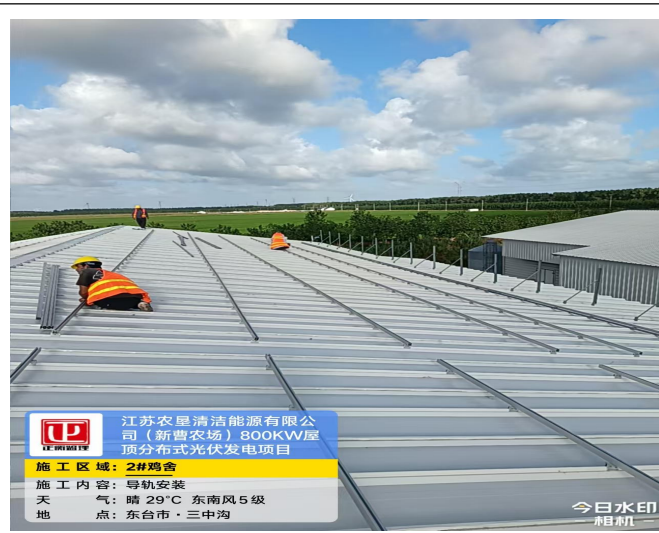
2#鸡舍导轨散料、安装
