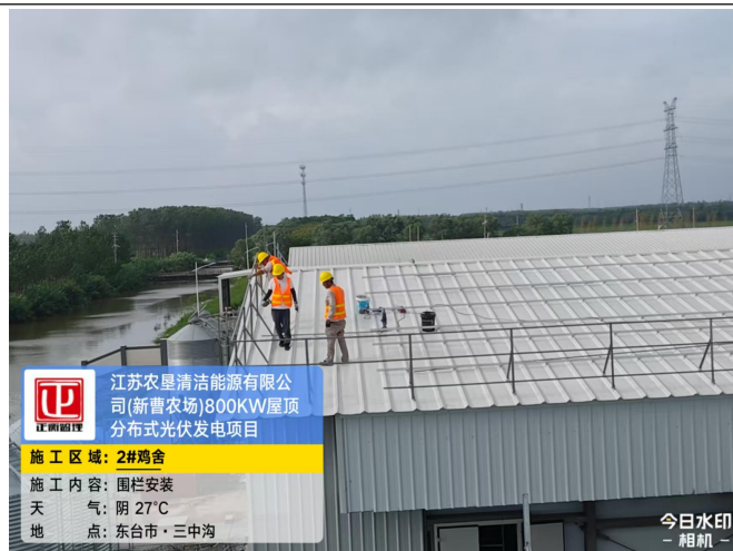
2#鸡舍围栏安装
