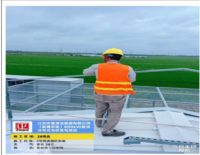
2#鸡舍围栏安装
