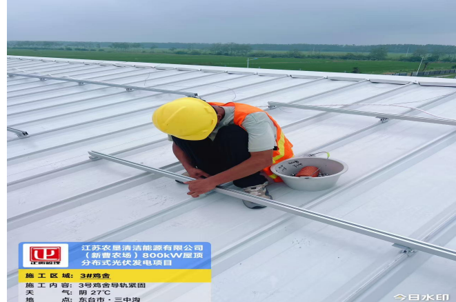
3#鸡舍导轨安装
