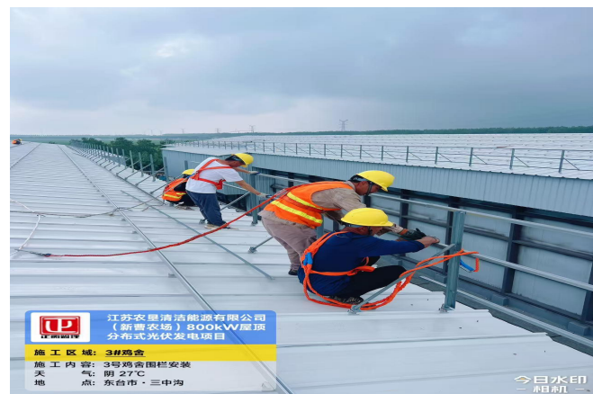
3#鸡舍围栏安装
