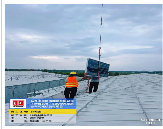
2#鸡舍组件吊运
