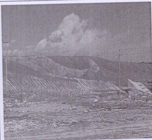
支架安装了 728 组
