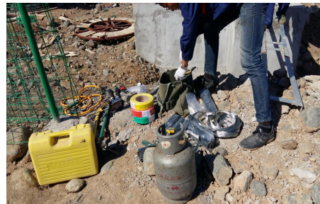
(光伏区电气标示涂刷和防火封堵)
