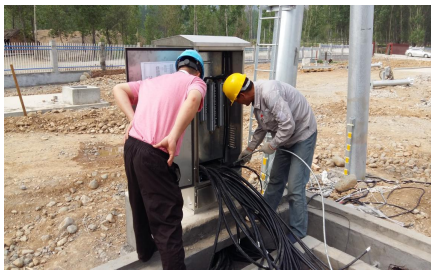
( 监理旁站升压站现场)
