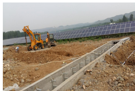
(集线线路电缆沟开挖)
