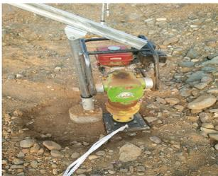
(桩基础二次夯实确保拉拔强度)
