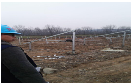
（旁站支架安装）
