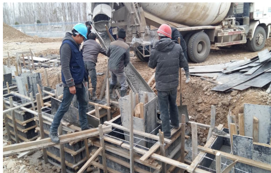
(监理检查主变基础施工现场)
