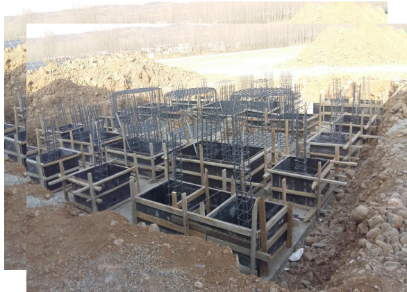
(SVG 基础施工现场)
