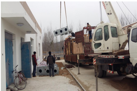
(升压站电气设备进场)
