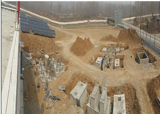
(升压站土建室外基础浇筑完成)
