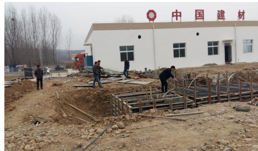
(业主检查主变基础施工现场)
