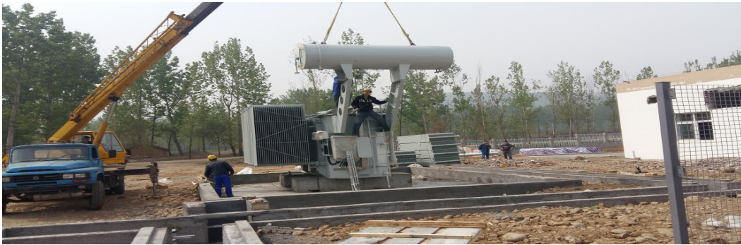
（主变附件安装现场）
