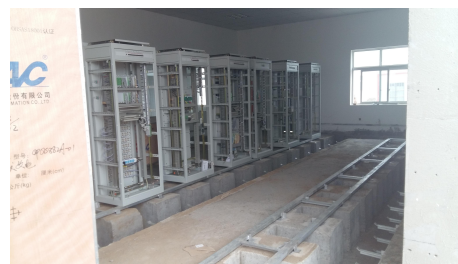
( 二次盘柜安装 )
