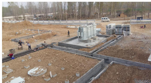
(室外电缆沟浇筑成型)
