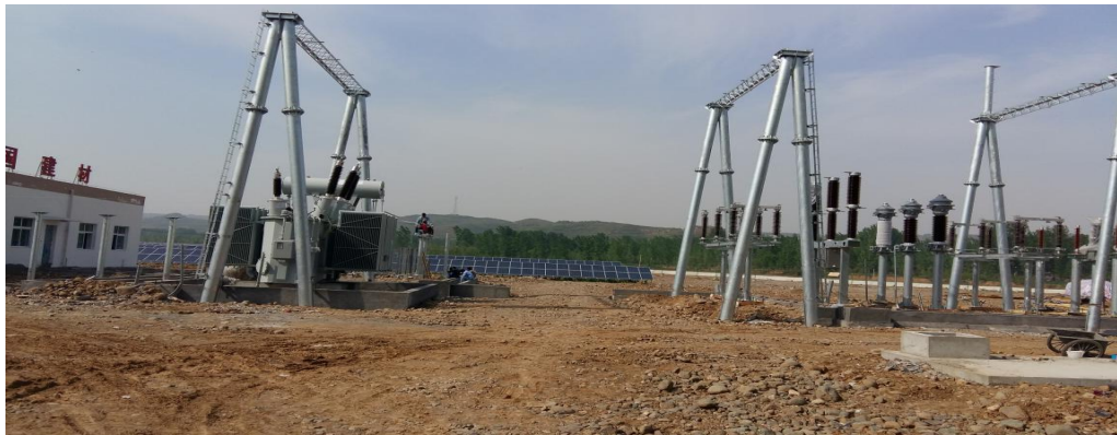
（升压站室外本月施工全景）
