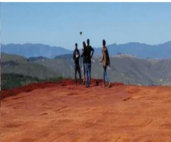
现场验收1#地块坐标、场平情况
