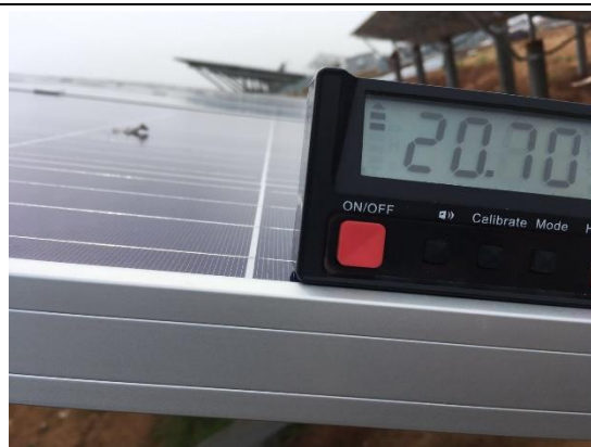
组件安装角度检查
