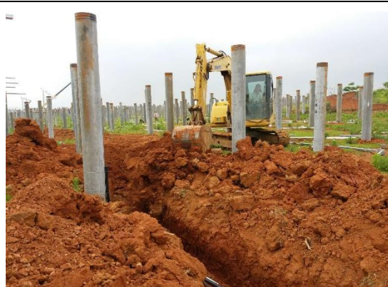
电缆沟土方回填
