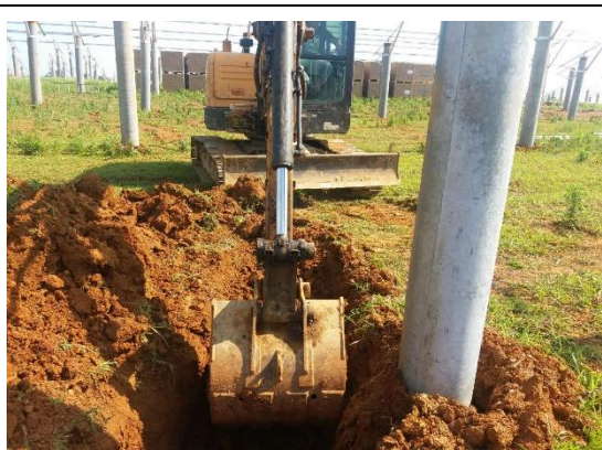
电缆沟土方开挖
