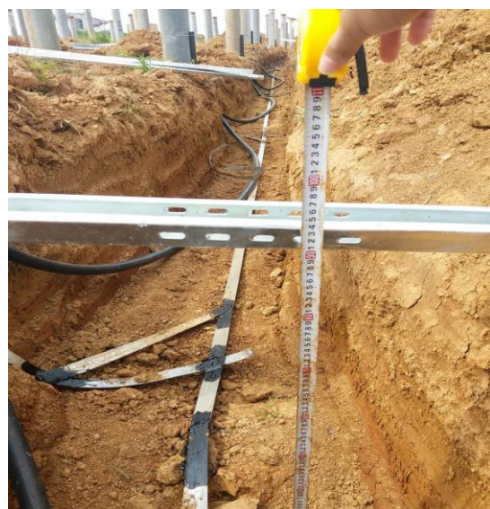
电缆沟深度测量
