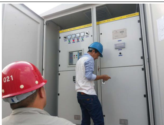
送电前箱逆变检查准备
