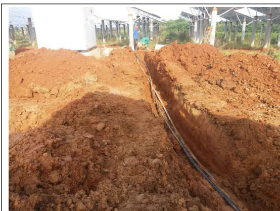
电缆过路段施工
