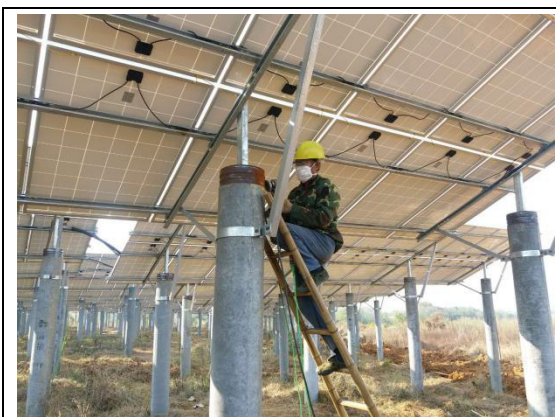
32 区桩头打磨除锈
