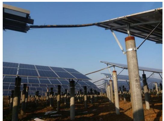
24 区板间线缆固定
