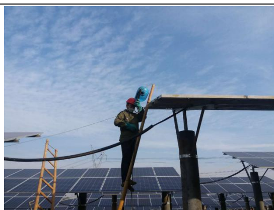
26 区横向接地焊接
