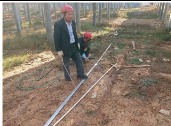
接地扁铁焊接加工
