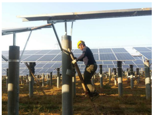
25 区桩头刷底漆
