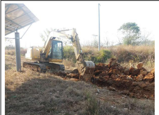
祝站一区外网接地沟开挖
