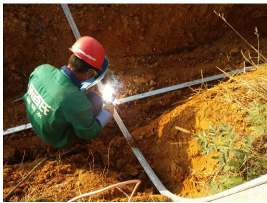
25 区接地扁铁焊接
