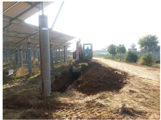
27 区接地沟开挖
