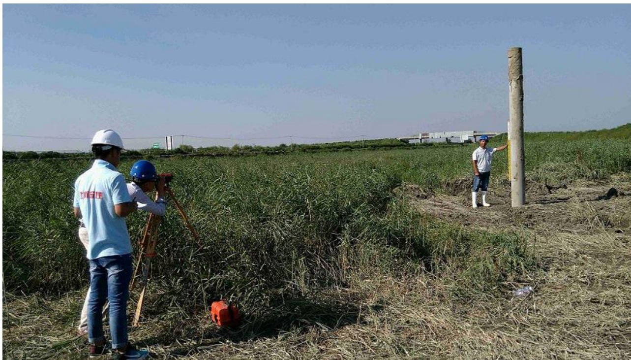
（1）、试桩施工复测
