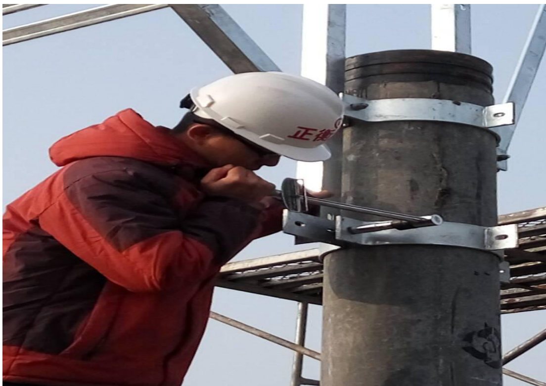
5、支架螺丝紧固检查
