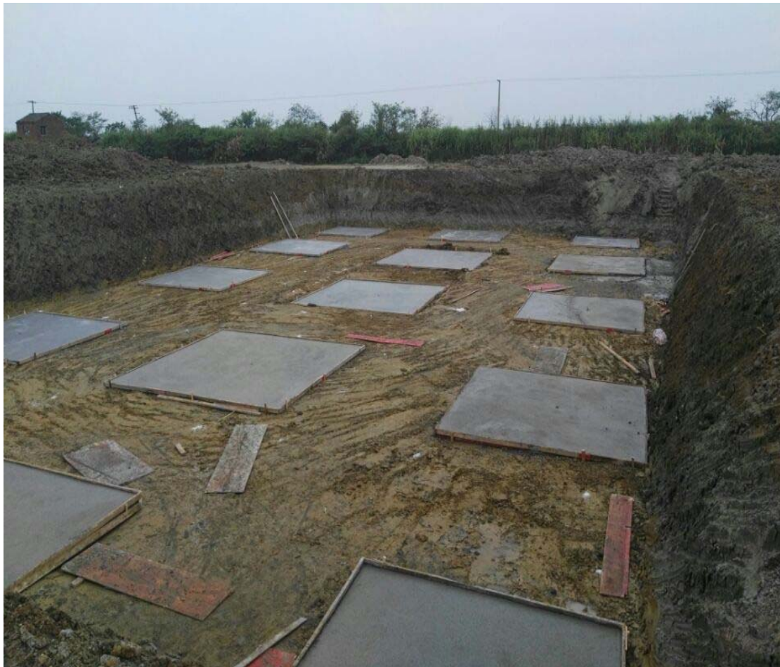
配电楼基础垫层
