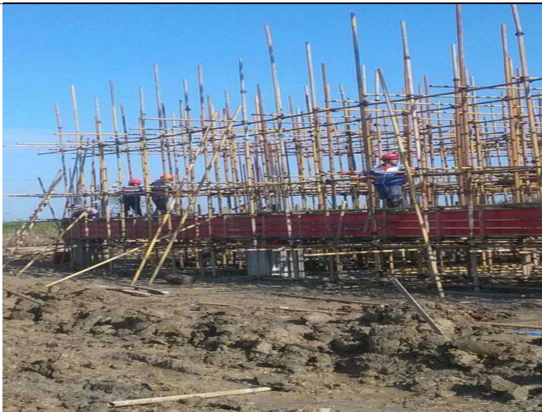
配电楼满堂架施工
