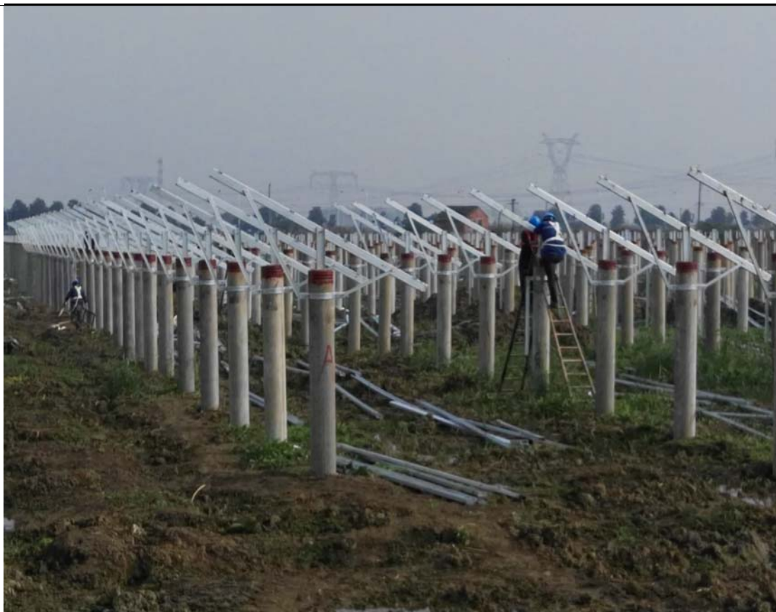
光伏区支架安装。
