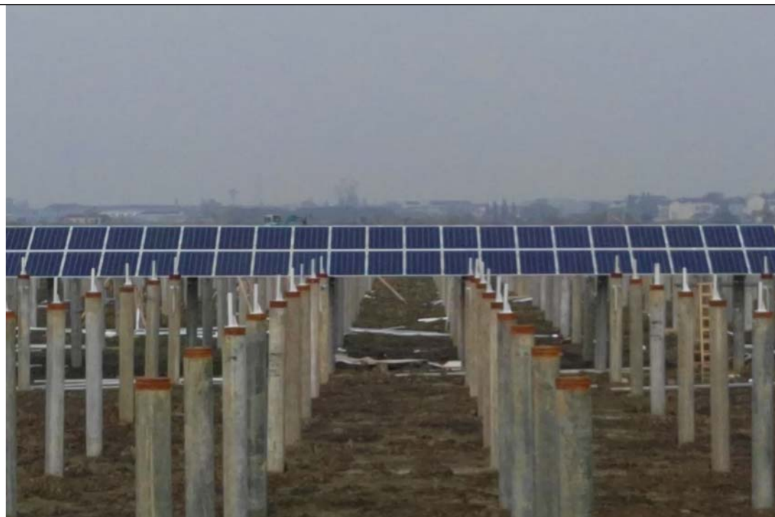
光伏区组件试装。
