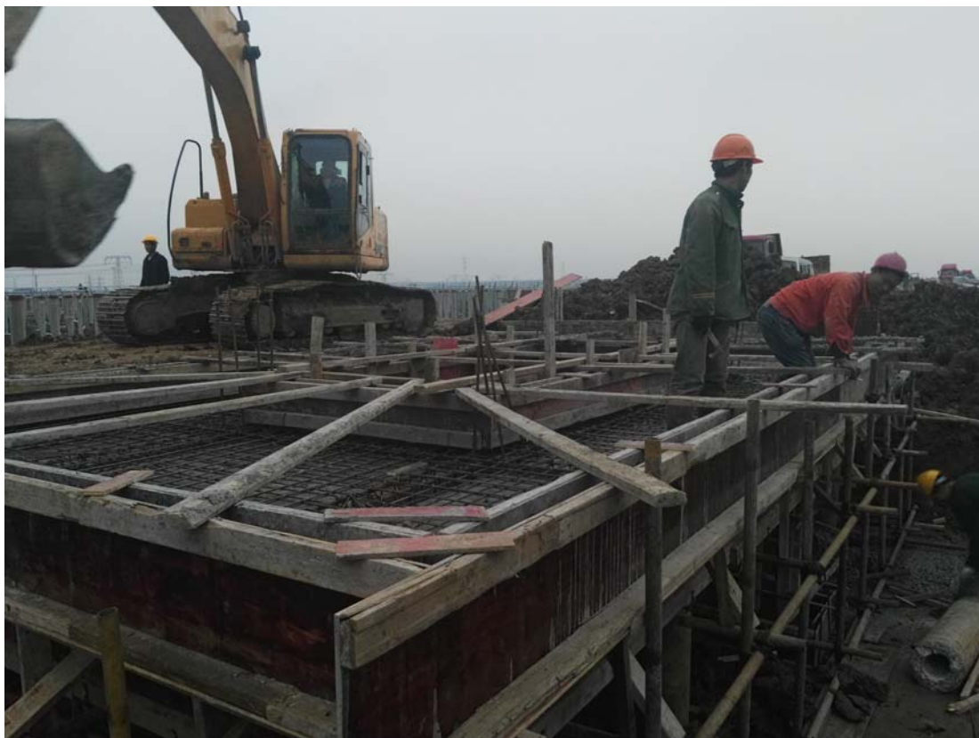
光伏区箱变基础平台浇筑。
