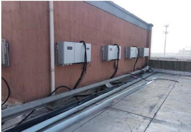
4. 浙江中意轻纺有限公司分布式光伏发电项目基座浇筑已完成，有两个屋面组件、桥架、电缆放线、汇流箱、逆变器、接地扁铁等工序已完成，具备并网条件，其余四个屋面支架、组件安装正在施工，箱变配电柜土建、电缆沟工序正在是施工；
