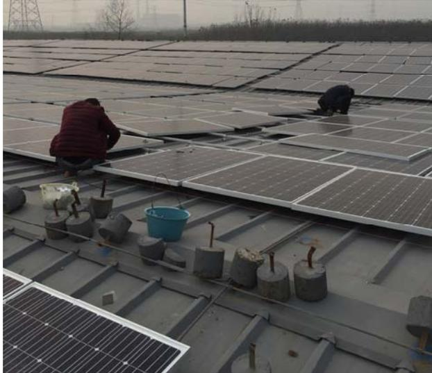
3. 绍兴君盛包装材料有限公司分布式光伏发电项目组件安装已完成，桥架、接地扁铁安装工序正在施工，汇流箱、逆变器已到货未安装，其余工程均未开展；
