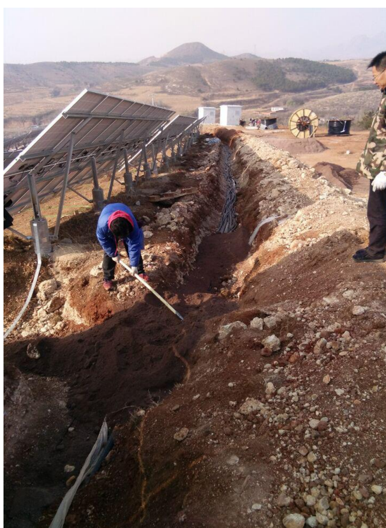
4、1*4 电缆穿管预埋深度不符合设计要求
