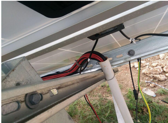
5、北台子电缆套管不符合规范要求
