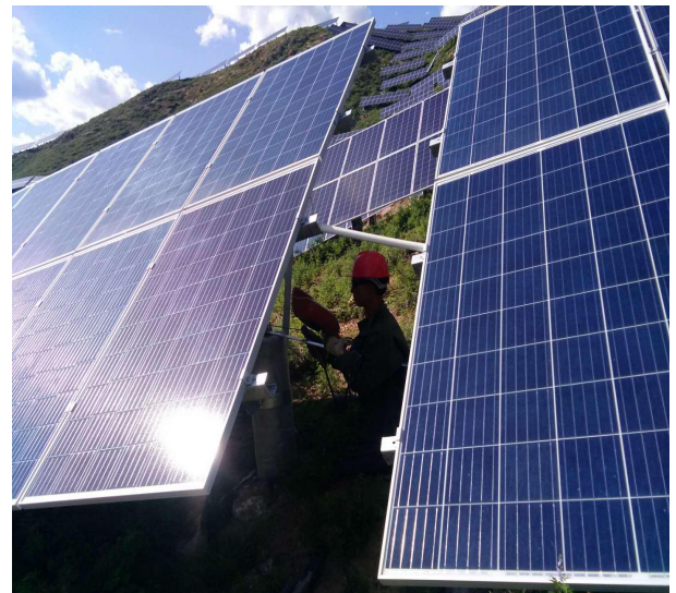
下三家场区接地扁铁焊接
