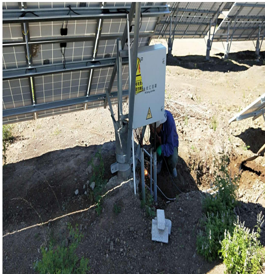
联合场区接地扁铁焊接
