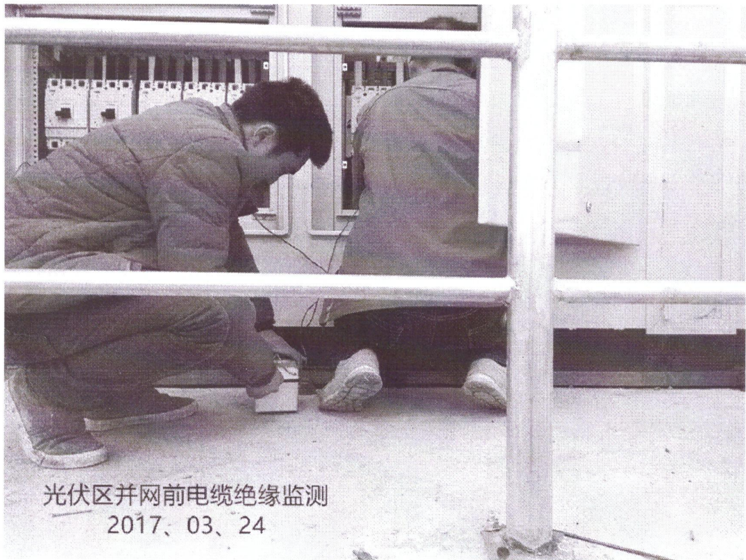
光伏区并网前 35KV 电缆绝缘测试
