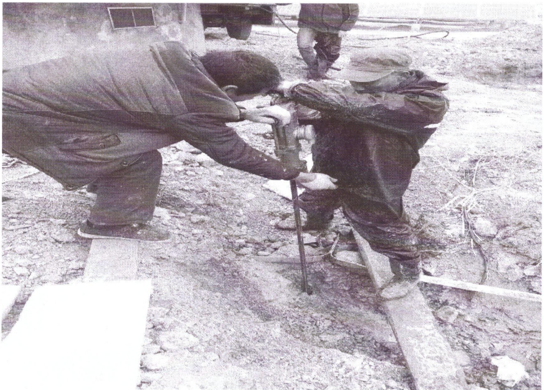
垂直接地极引孔施工
