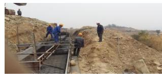
3、本月挡土墙片石砌筑 75% 施工质量符合要求；综合楼从基础开挖施工至综合楼承台柱箍筋安装完成；综合楼地梁放线、开挖；地梁砖胎模砌筑完成 60%，施工质量符合要求。
