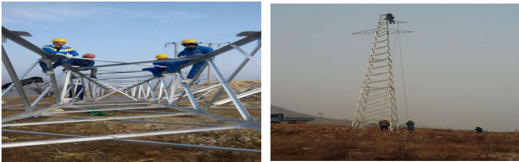
（外线杆塔塔组立）
