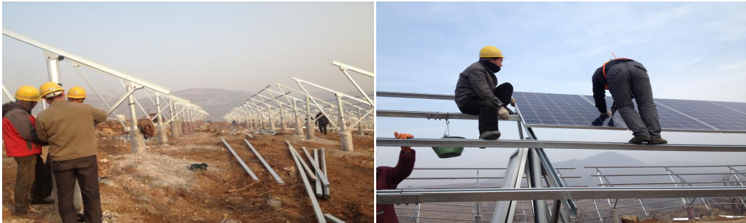
（1#、2#地块组件安装施工）
