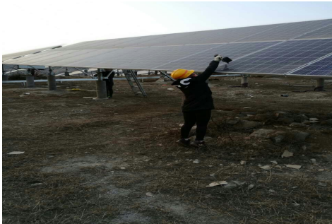
（光伏区组件压块、螺栓整改情况，2#地块电压电缆敷设）
