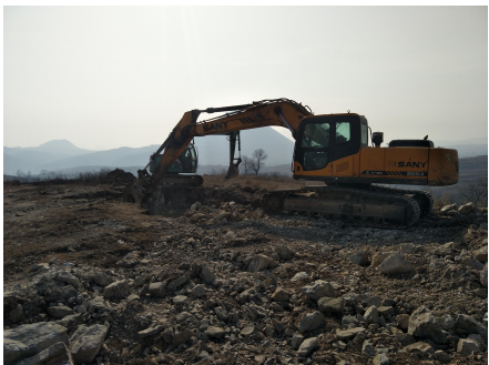
（外线杆塔架线；场内集电线路基坑开挖）
