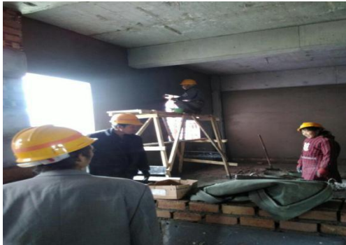
（综合楼、35KV 配电间室内抹灰）
