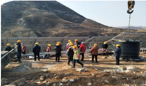
（光伏区组件压块、螺栓整改情况，2#地块电压电缆敷设）
