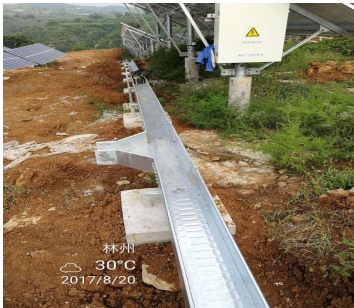
（光伏区 5#地块桥架基础浇筑、电缆槽盒安装）
