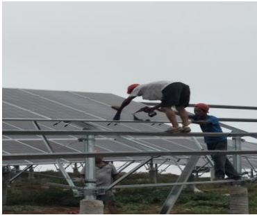
（光伏区 5#地块灌注桩施工、组件安装）
