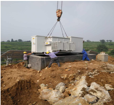
（光伏区 5#地块组件接线及箱变吊装）
