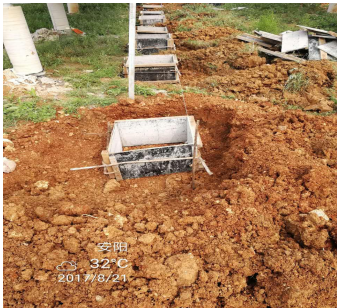
（光伏区 5#地块桥架基础浇筑、电缆槽盒安装）
