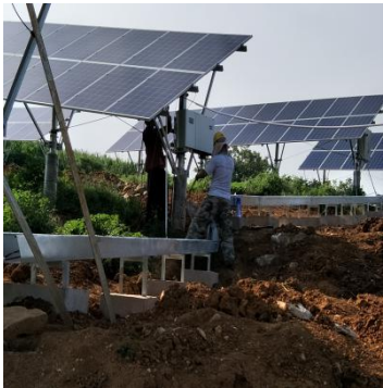
（光伏区 5#地块组件接线及箱变吊装）
