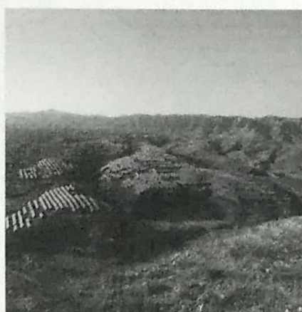
5号地组件安装完成
