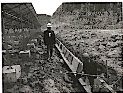
光伏区巡视排水沟施工
