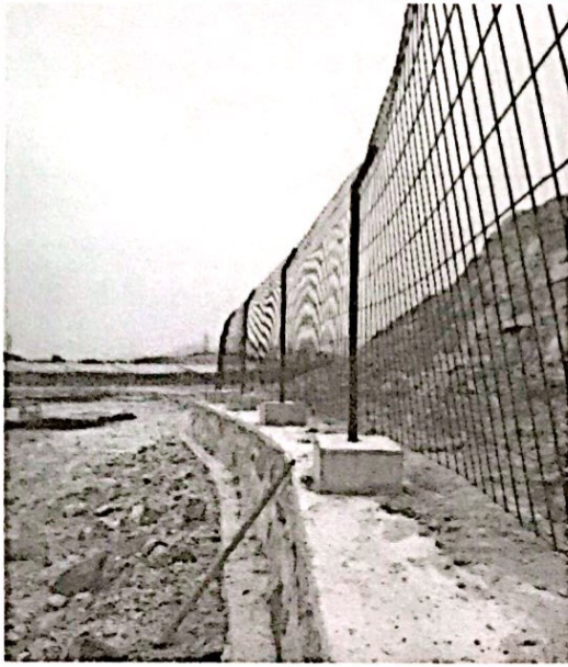
场区围栏安装
