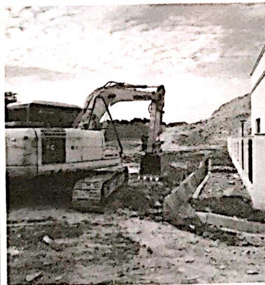
开关站外排水沟填土
