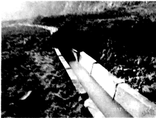
光伏区排水沟巡视
