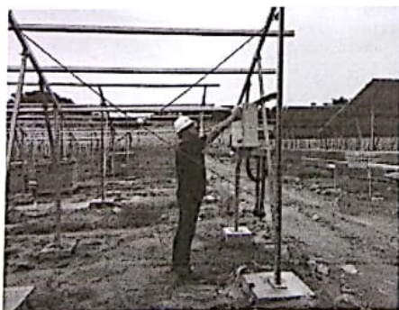
检查汇流箱安装质量
