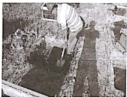
支架基础开槽
