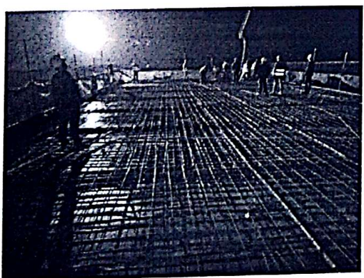
配电房二层梁板柱商砼浇筑
