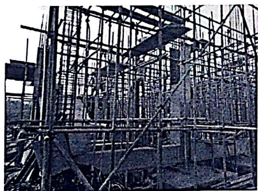
配电房搭设脚手架
