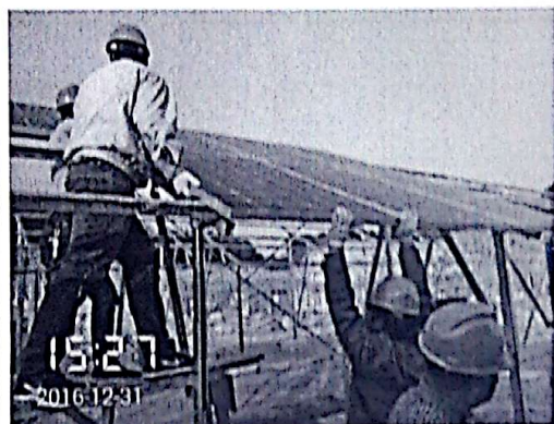
光伏区 8#方阵组件安装
