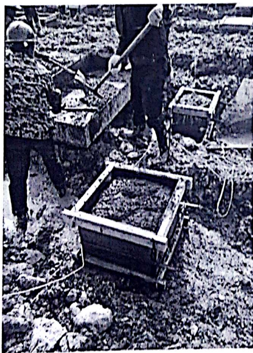
支架基础砼浇筑
