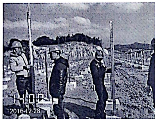
光伏区 8#方阵支架安装
