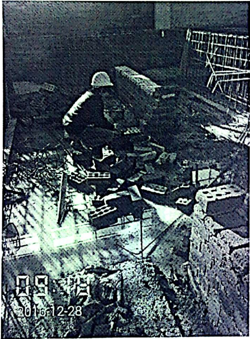
配电房电缆沟砌筑
