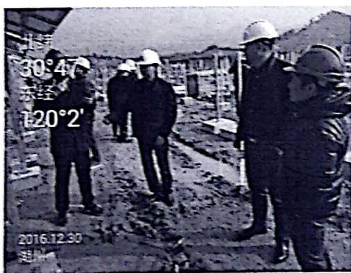
业主、总包现场检查工作
