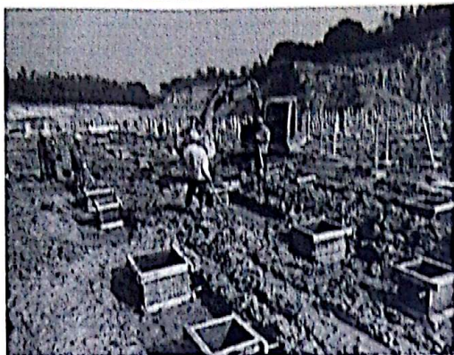
光伏区 7#方阵支架基础 浇筑
