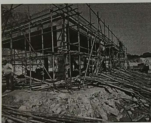
仓库模板拆除
