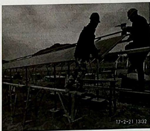
支架与组件安装
