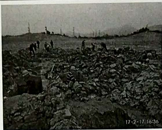
支架基础土方开挖
