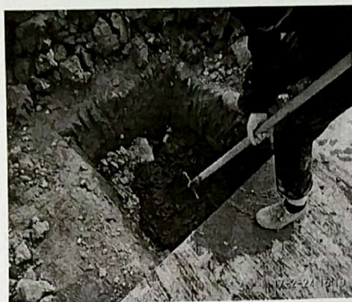
支架基础浇筑垫层
