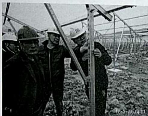
光伏区支架质量检查
