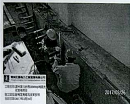
配电室电缆沟支架安装
