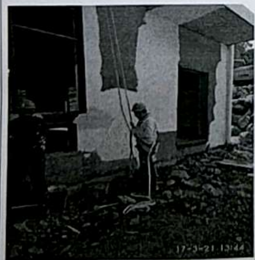
配电室外墙抹腻子
