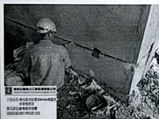
配电室穿线管开槽
