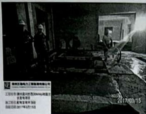
配电室地坪浇筑
